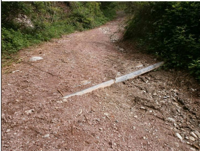
Marcati processi erosivi lungo il sedime stradale e interrimento di una canaletta trasversale.
