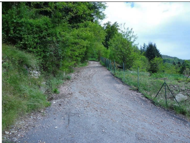
Stessa tratta, ripresa da valle, evidenziante la breve asfaltatura; a sx la cunetta laterale è parzialmente ostruita da residui vegetali.
