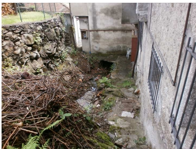
Riale a: imbocco tratta in sotterranea a monte di Via S. Fermo, presenza in alveo di rifiuti.
