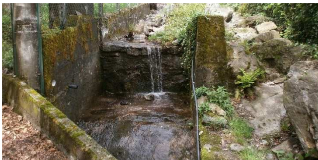
Riale c: tratta d'alveo di monte artificializzata con serie di soglie.
